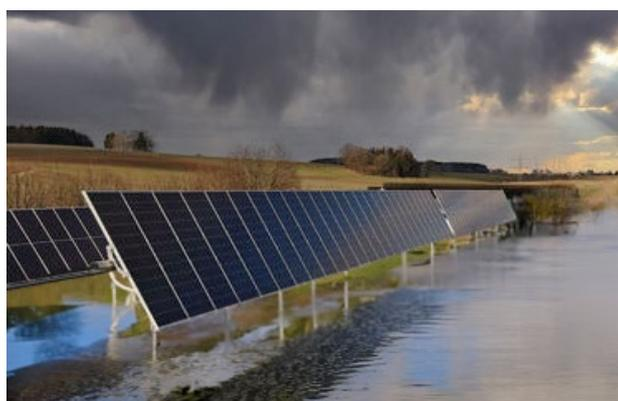
Die Solar-Tracker Anlagen stehen hoch genug über dem Boden, um auch bei Überflutungen weiterhin Strom zu erzeugen. Dadurch können die Flächen effizient genutzt und der Wert der landwirtschaftlichen Flächen nahezu erhalten bleiben. Die Trackeranlagen sind so konzipiert, dass sie der Wasserbelastung standhalten und gleichzeitig die Sonneneinstrahlung optimal nutzen.
