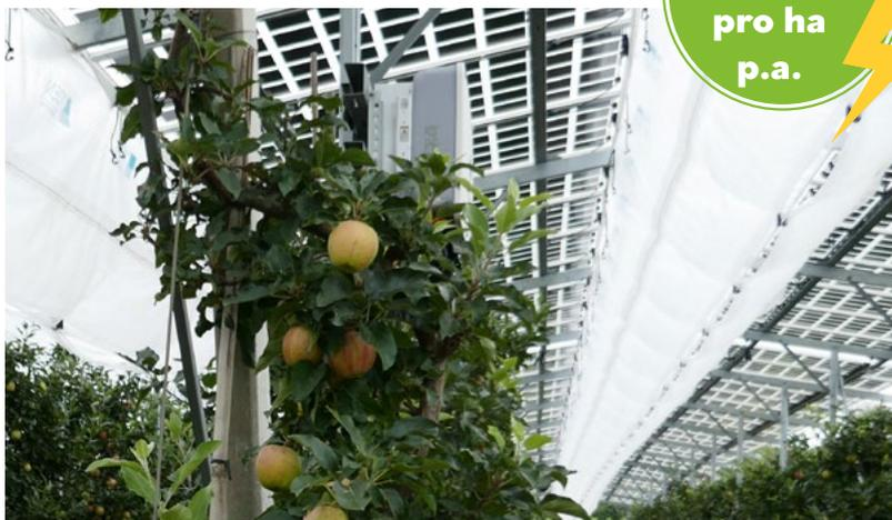
Die Agri-PV-Pilotanlage oberhalb der Apfelplantage des Obsthofs Bernhard besteht aus einem Metallgerüst, auf dem Solarmodule montiert sind. Es handelt sich um besonders stabile Almaden-Doppelglasmodule mit einer Transparenz von ca. 40%. Der erzeugte Ökostrom wird in das Netz des Energiever-
