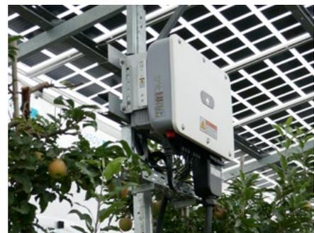
Sichere Montage von Wechselrichtern
