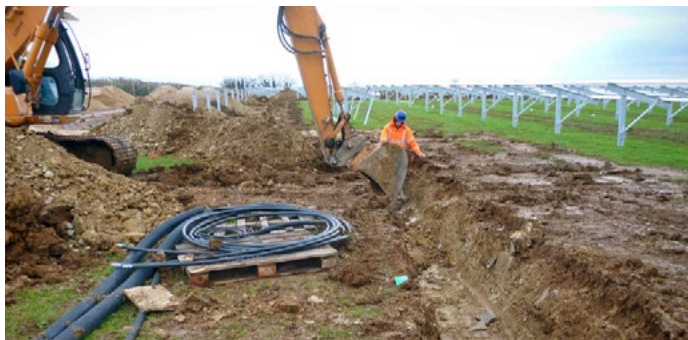
Ausheben von Kabelgräben und die entsprechenden Fundamentarbeiten für die Trafostationen.
