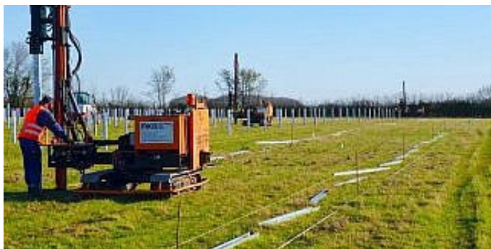
Rammen der Tragprofile. Montage der projektspezifischen Unterkonstruktion auf den Mastfundamenten.
