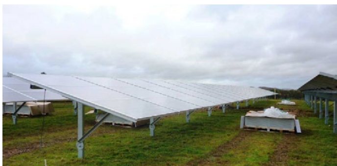
Errichtung der kompletten Zaunanlage
