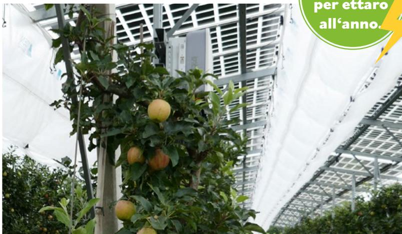
Il sistema pilota Agri-PV sopra il meleto dell'azienda frutticola Bernhard consiste in una struttura metallica su cui sono montati i moduli solari. Si tratta di moduli Almaden a doppio vetro particolarmente stabili, con una trasparenza di circa il 40%. L'elettricità verde generata viene immessa nella rete
