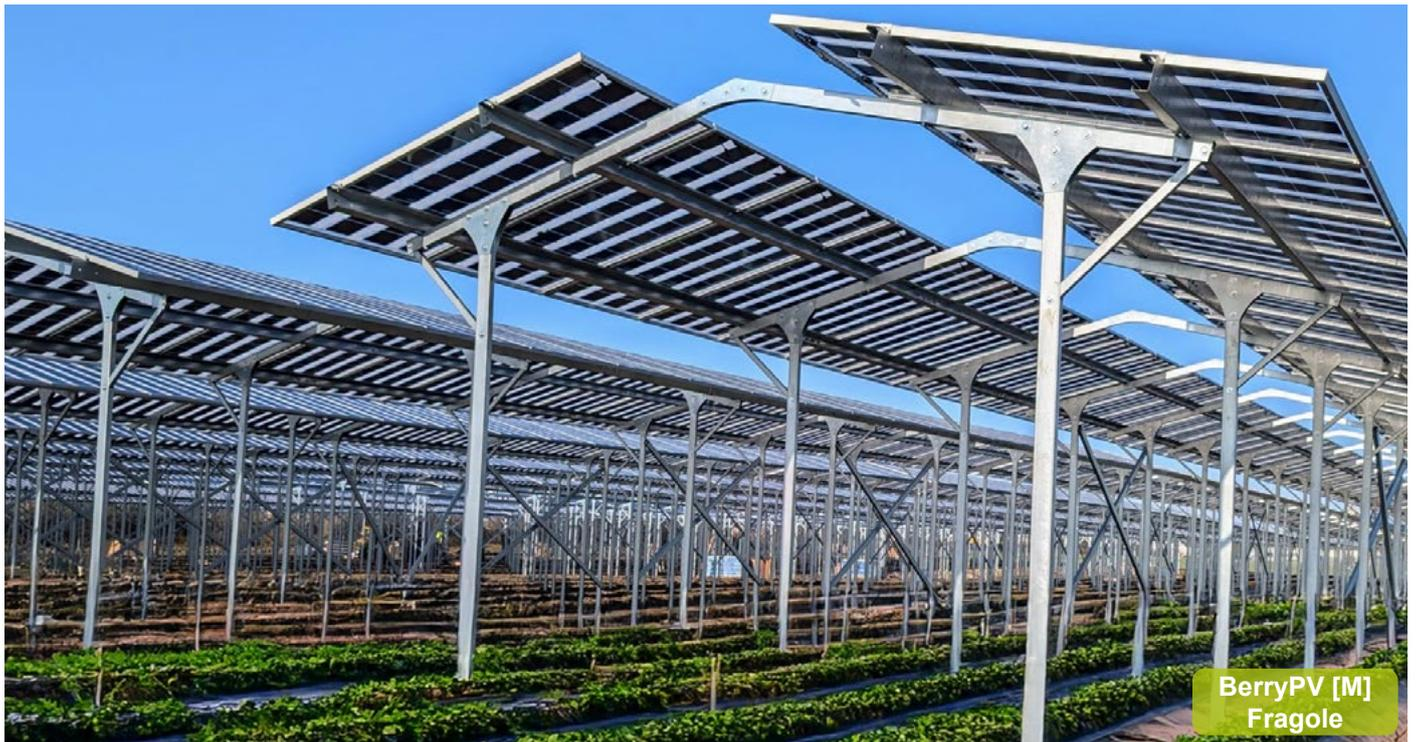
I moduli fotovoltaici semi trasparenti proteggono piante da condizioni meteorologiche estreme quali il sole cocente, la Grandine, il forte vento e pioggia. Con un ingresso della luce sulle coltivazioni di circa l'85% si ottiene un equilibrio ottimale tra protezione e produzione di energia elettrica
